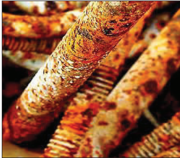
Figura 1- 10 CORROSIÓN POR ALTAS TEMPERATURAS
