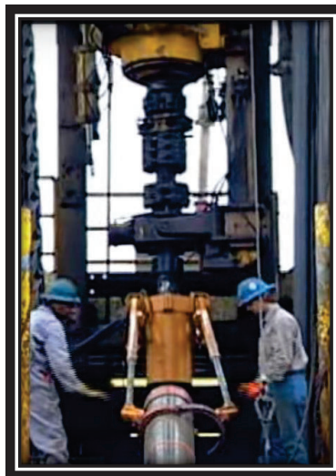
FIGURA 3. 6: CORRIDA DE CASING MEDIANTE CDS
