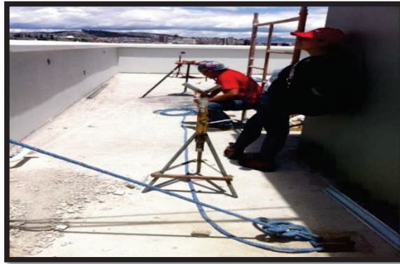
Figura 1-4.- Apoyos para soldar tubería en azotea
