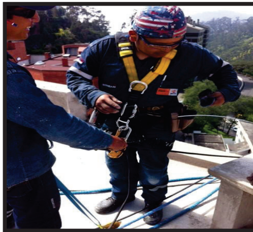
Figura 1-7.- Colocación de equipo de seguridad (Fuente: Propia)
