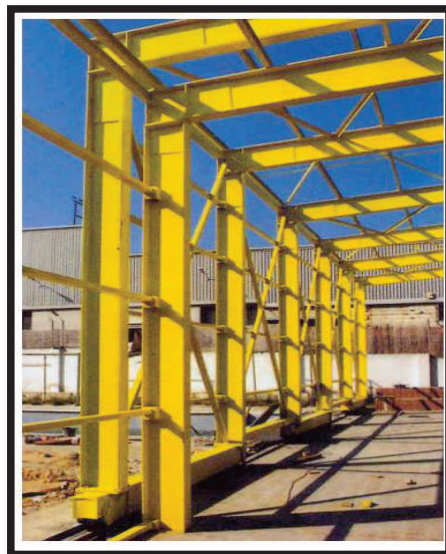
Figura 2-23.- Arriostramientos ubicados en el conjunto.
