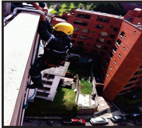
Figura 1-10.- Personal técnico colocando anclajes.
