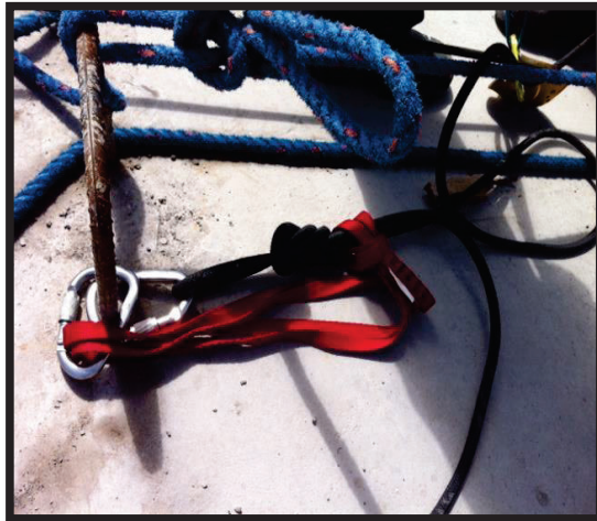
Figura 1-8.- Fijación de la línea de vida (Fuente: Propia)
