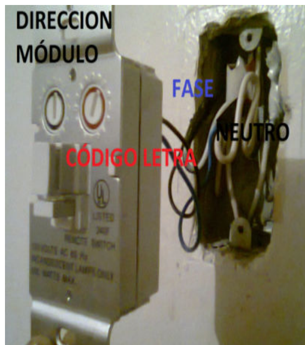
Ilustración 13. Módulo WS 467 remplazando a un interruptor de pared común.
