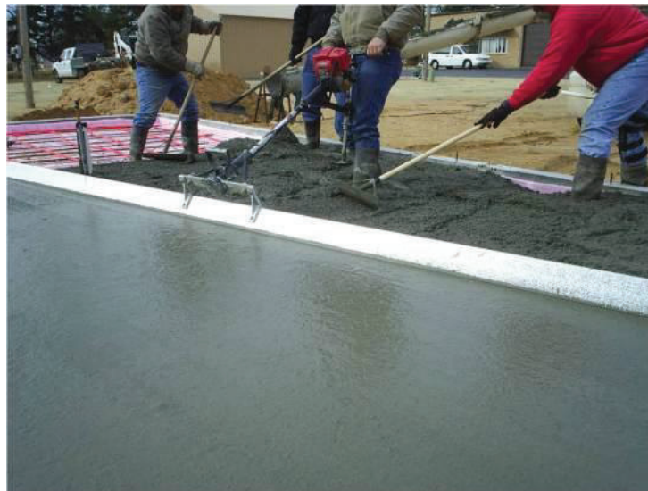
Figura 2.23: Extendido y Compactado del Hormigón
