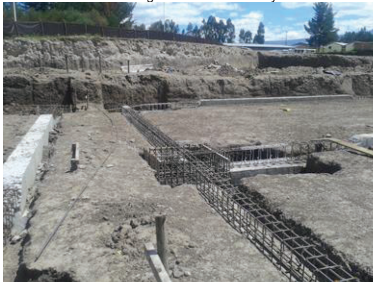
Construcción de Vigas de Cimentación y Pedestales
