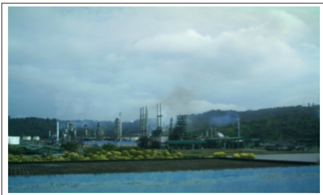
Figura 1.28- Emisiones Gaseosas de chimeneas (Refinería Estatal Esmeraldas)
