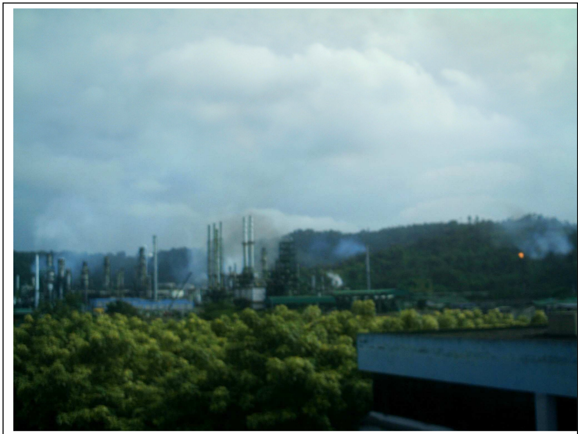
Figura 1.12.- Atmósfera Industrial Refinería Estatal Esmeraldas
