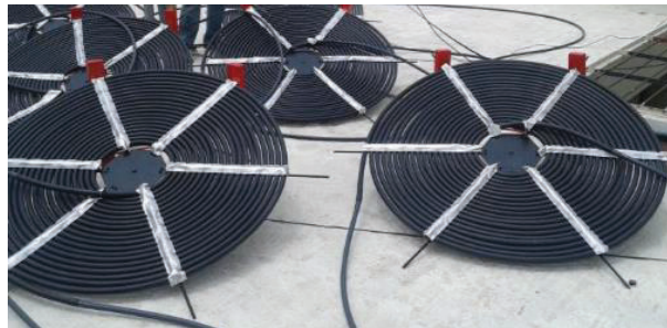
Figura 2.19. Colector solar enrollado de manguera Fuente: (Nojiri, 2009)
