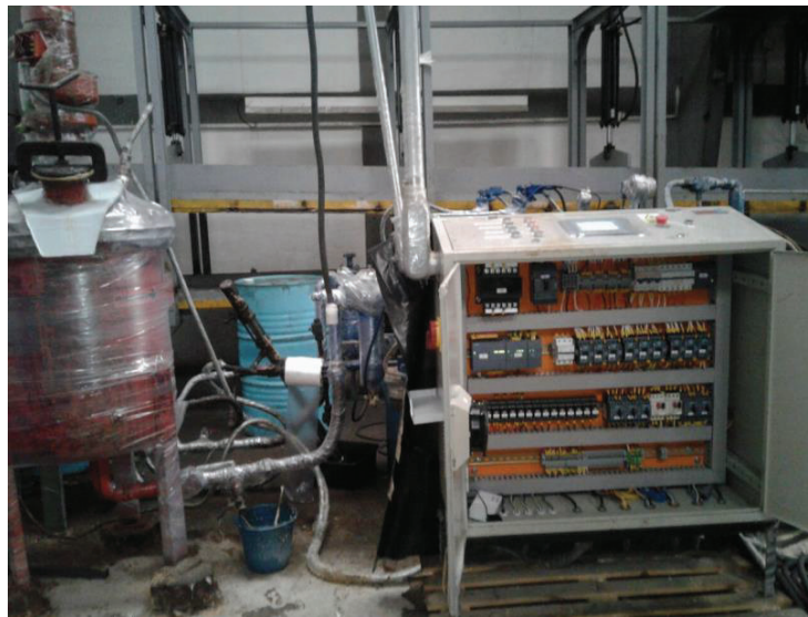
Figura 3.35: Pruebas de Inyección de Poliuretano
