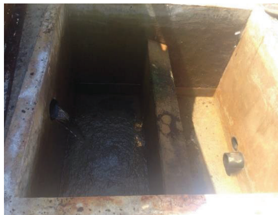
FOTOGRAFÍA 6. INTERIOR DEL TANQUE DE CAPTACIÓN DE LA VERTIENTE LA CHELITA
