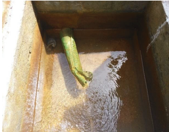
FOTOGRAFÍA 4. INTERIOR DEL TANQUE DE CAPTACIÓN EL CARMEN
