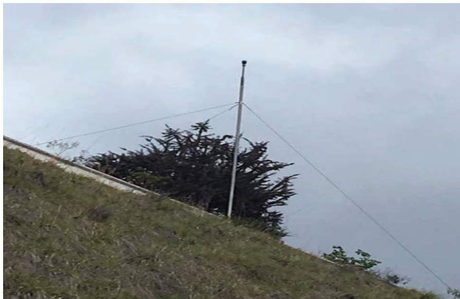
Figura 3.5 Pararrayo de la estación de servicios Petrocomercial Ponceano
