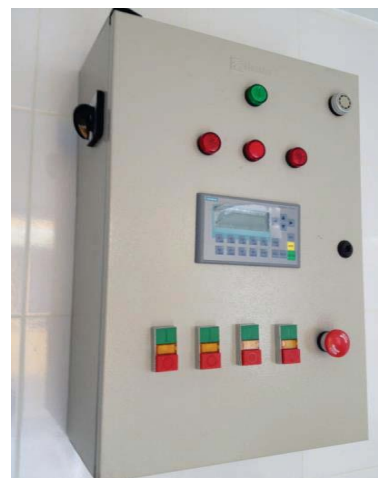
Fig. 1.8: Vista exterior del tablero.
