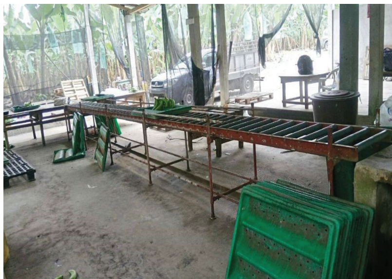
FOTOGRAFÍA 7.2 RECONOCIMIENTO DE LAS INSTALACIONES (BANDA PARA APLICACIÓN DE QUÍMICOS AL BANANO)
