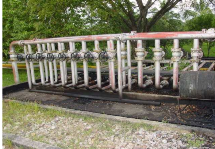
Fotografía 2.1: Manifold o Múltiple de Producción.
