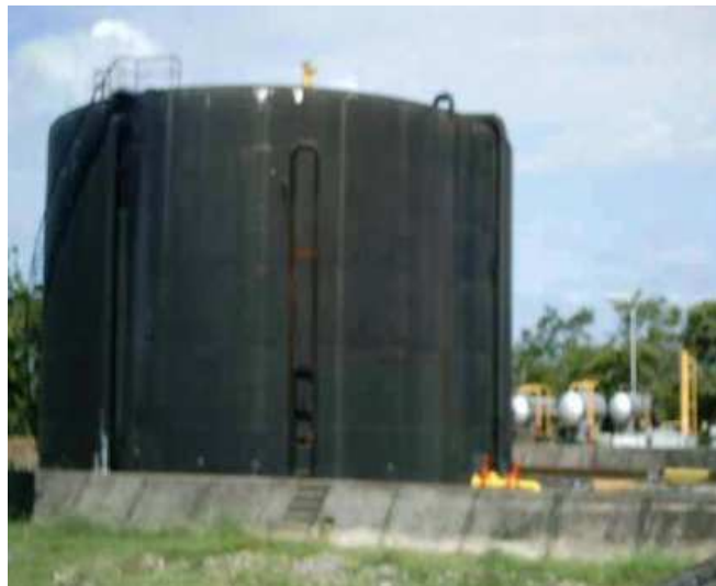
Fotografía 2.5: Tanque de Estabilización.
