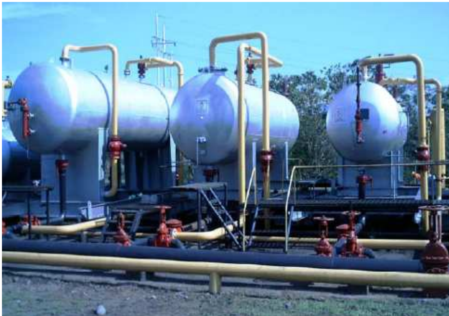
Fotografía 2.2: Separador Bifásico.
