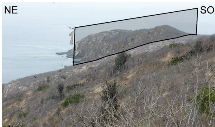
Figura 3.14. Fotografía tomada al sureste de la Isla de La Plata donde se evidencia la presencia de una falla.
