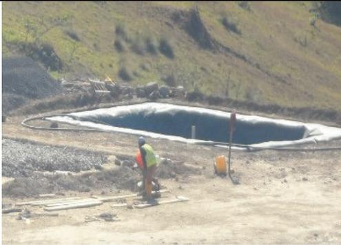
FOTOGRAFÍA 15: Celda de seguridad para residuos hospitalarios. (Relleno Sanitario Aliso)
