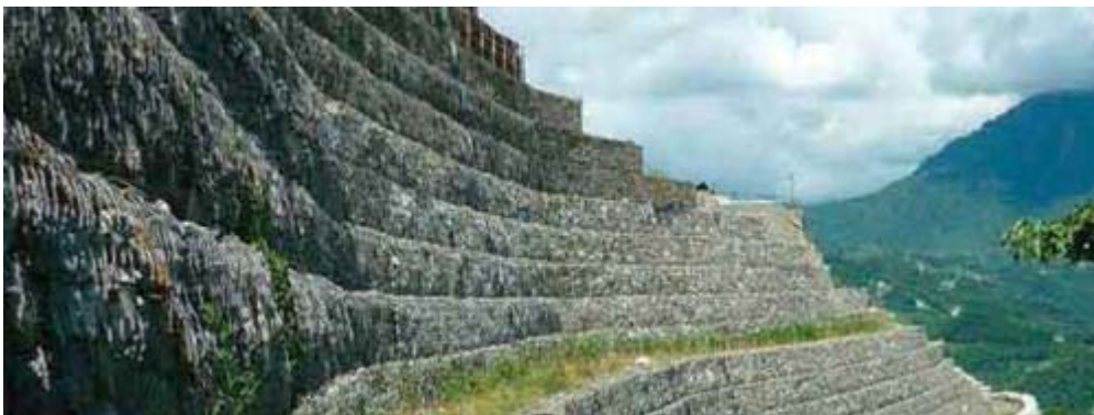
Fotografía 5.8. Muro de tierra reforzada (Terramesh, propiedad de Maccaferri). Fuente: Maccaferri, Maccaferri América Latina (2016).
