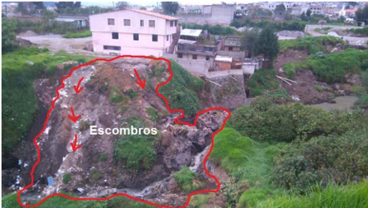
Fotografía 5.3. Escombros arrojados al talud en la casa presente en el perfil "C".
