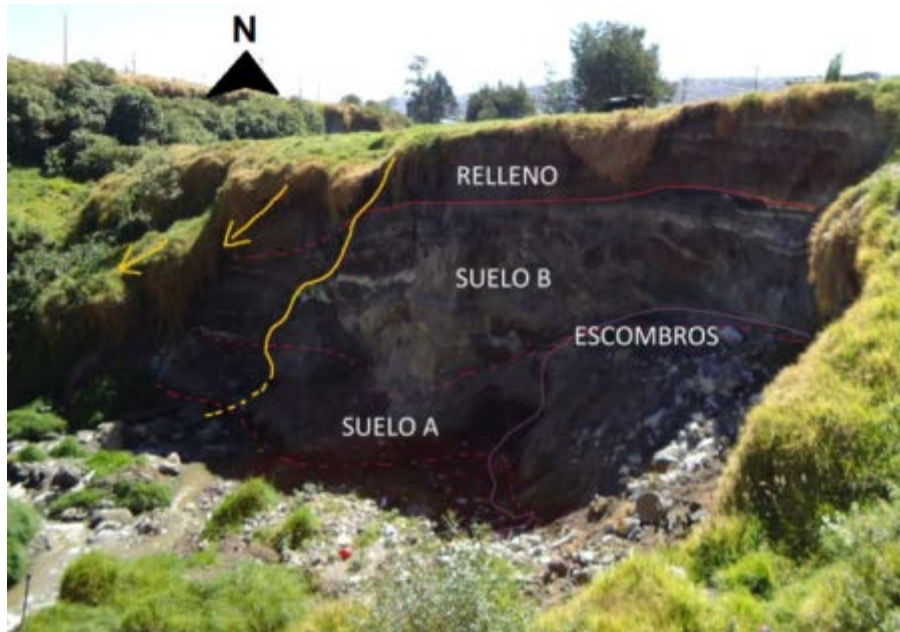
Fotografía 4.2. Material visible en un deslizamiento rotacional, se ven los tipos de materiales existentes.
