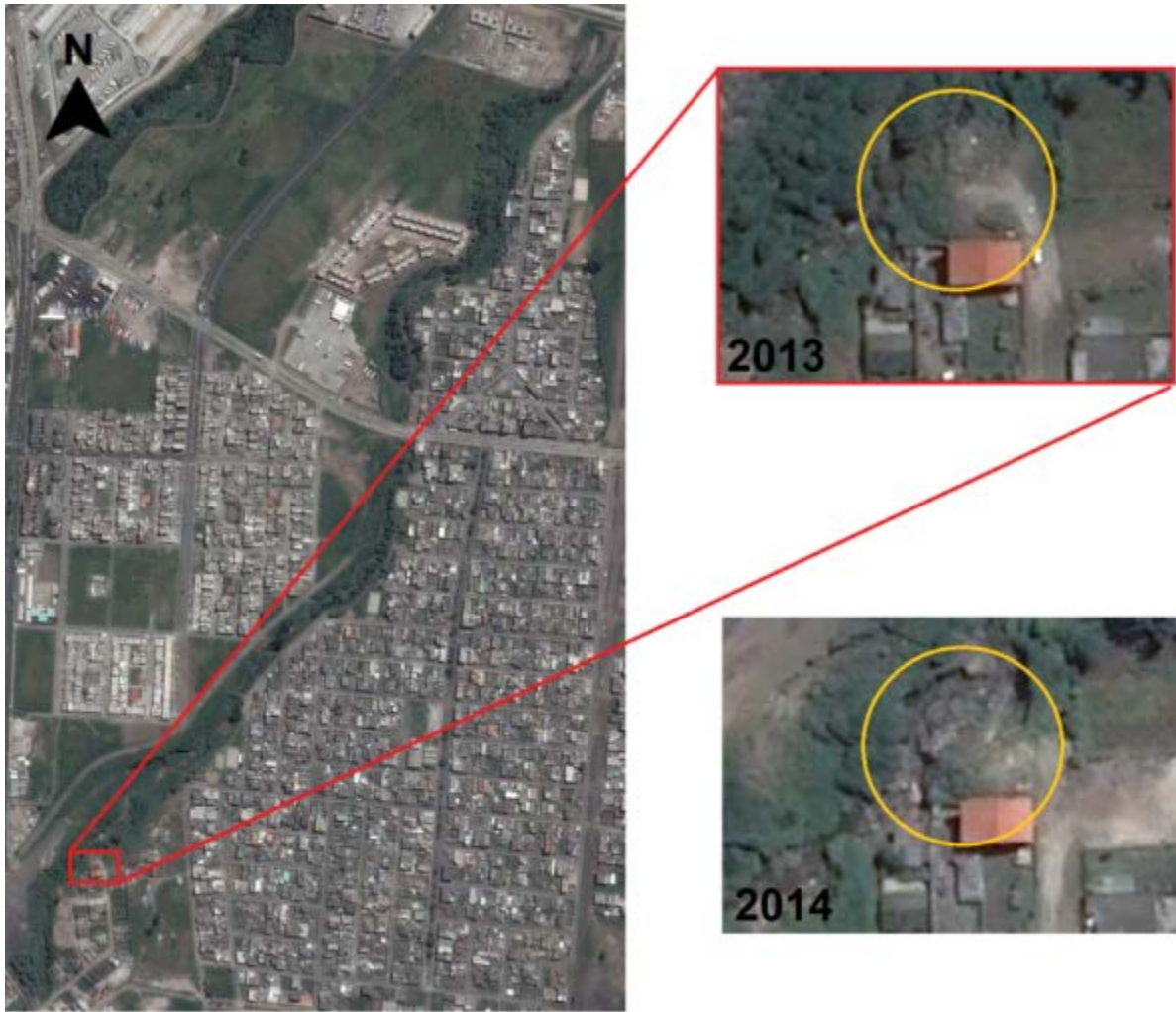
Figura 5.5. Deslizamiento ubicado en el perfil "C" en los años 2013 y 2014. Fuente: Google Earth, 2013-2014.
