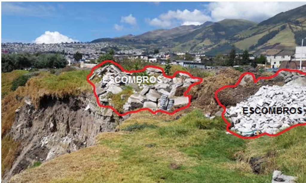
Fotografía 5.5. Escombros actuando como carga extra.
