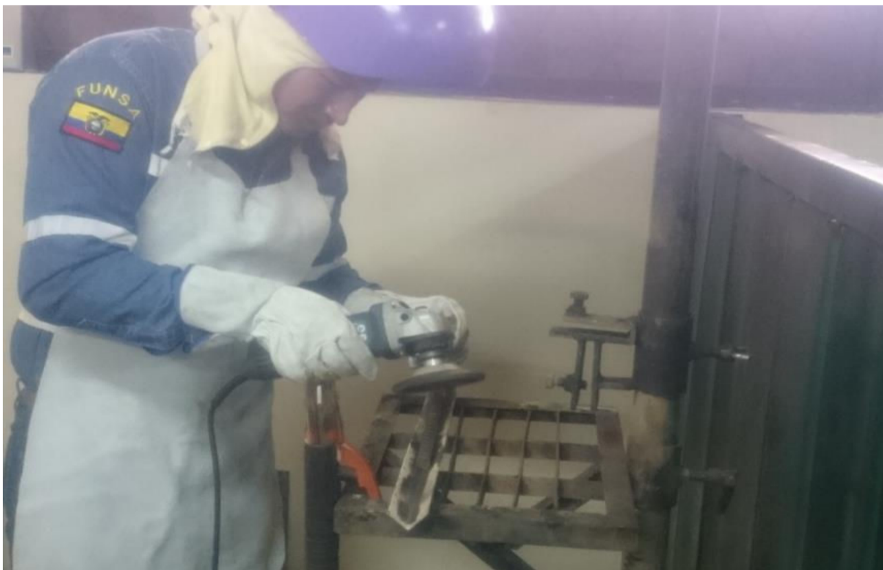
FIGURA 4.11: Limpieza de soldadura entre pases
