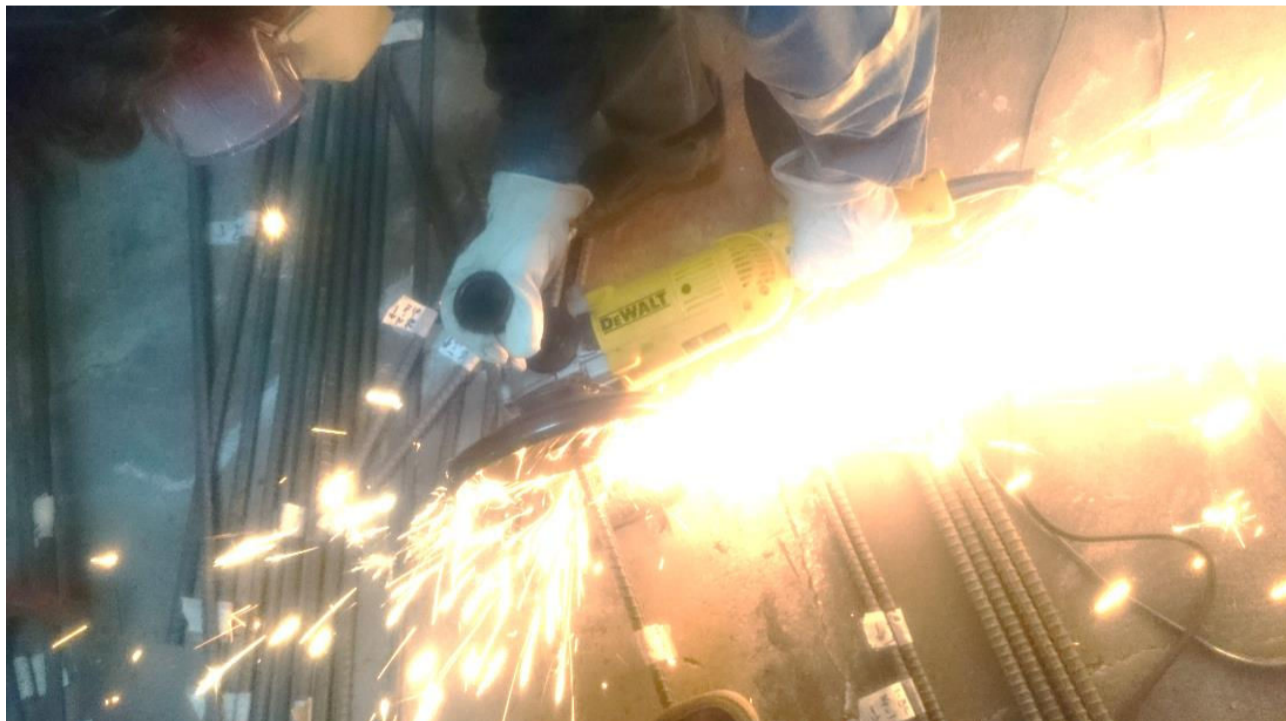
FIGURA 4.7: Corte de varillas – disco abrasivo
