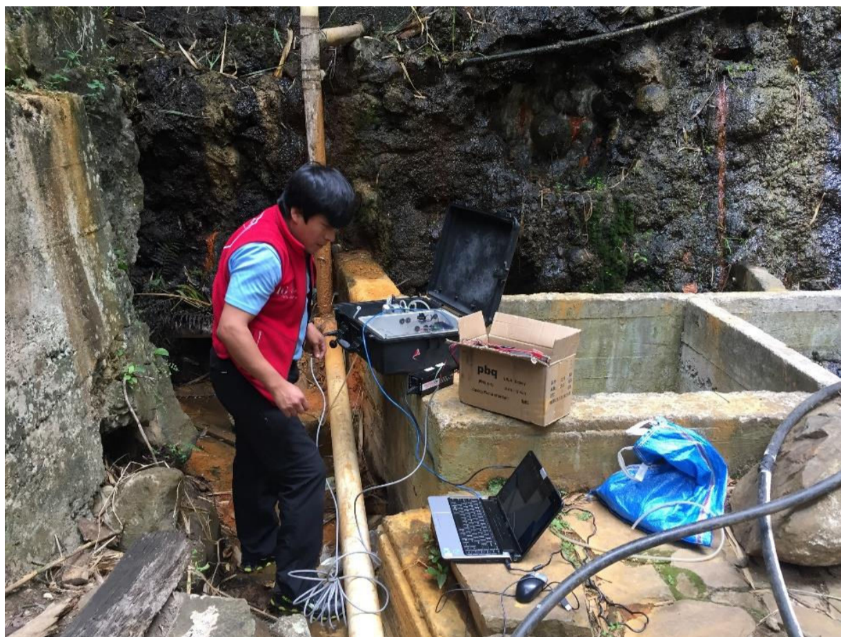
Figura 4.32. Instalación del sistema automático en la fuente termal Santa Ana.
