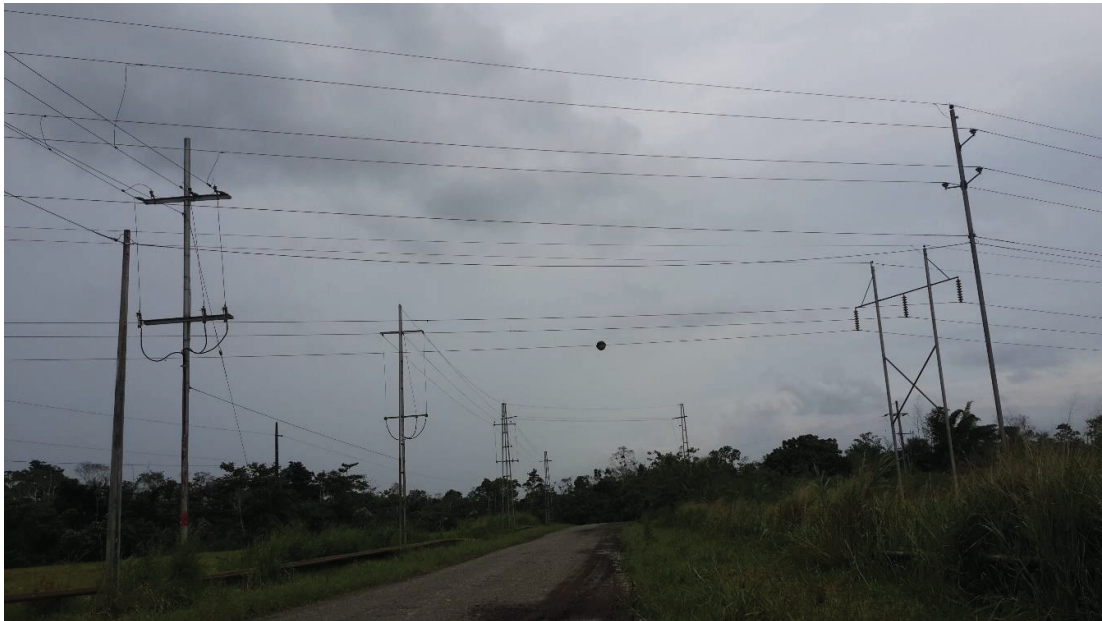
Figura 1 Tramo de red subterránea de primario de distribución de 13,8 kV por cruce con línea de trasmisión de 69 kV.
