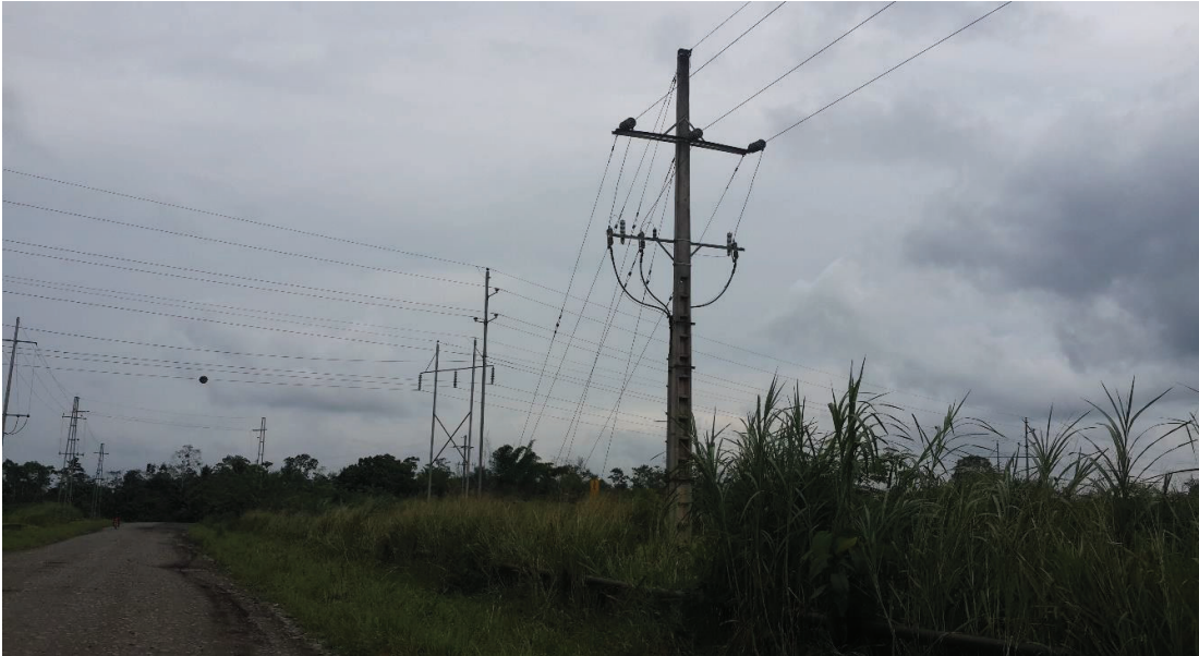
Figura 2 Terminal de red subterránea de 34,5 kV e inicio de red aérea de línea de subtransmisión del Campo MDC al Campo PBH (Enap Sipec-Sacha).
