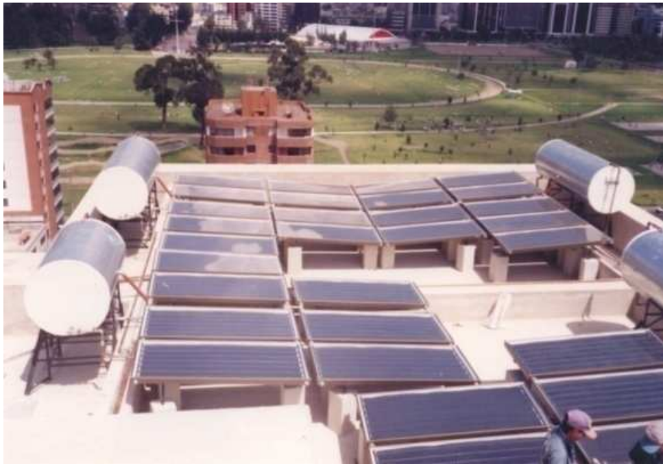
Fig.1.3.1- Colectores solares
