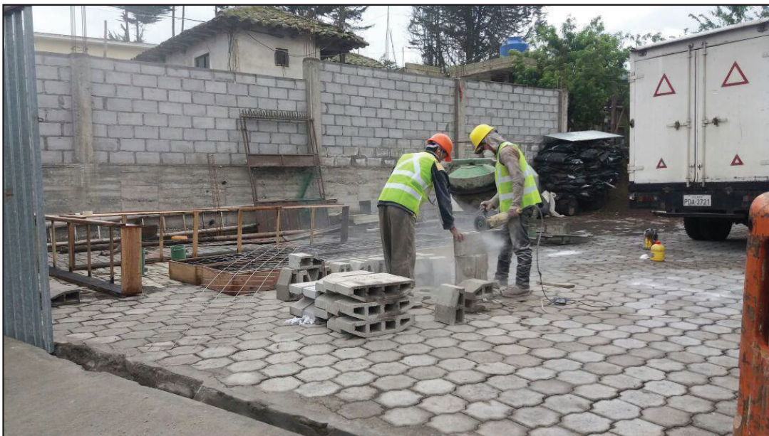
FOTOGRAFÍA. PREPARACIÓN Y CORTE ( r = \frac{1}{2} ) DE LAS BOVEDILLAS
