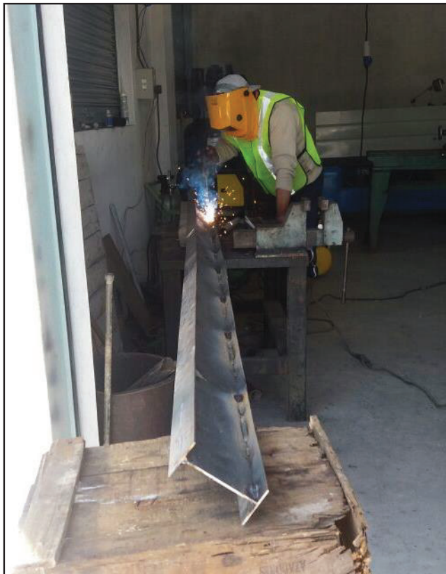
FOTOGRAFÍA. ENSAMBLE GENERAL DE VIGUETAS TIPO - I
