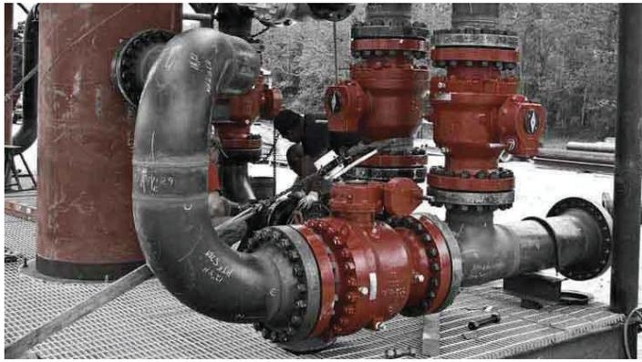
Figura I.18. Instalación o montaje en campo de secciones de tubería que fueron fabricados en taller.
