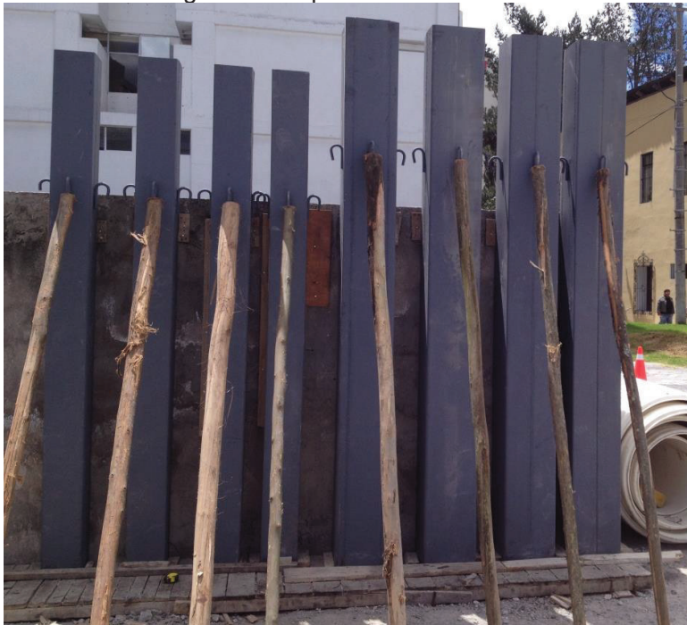
Fotografía 4.2 Apuntalado de columnas
