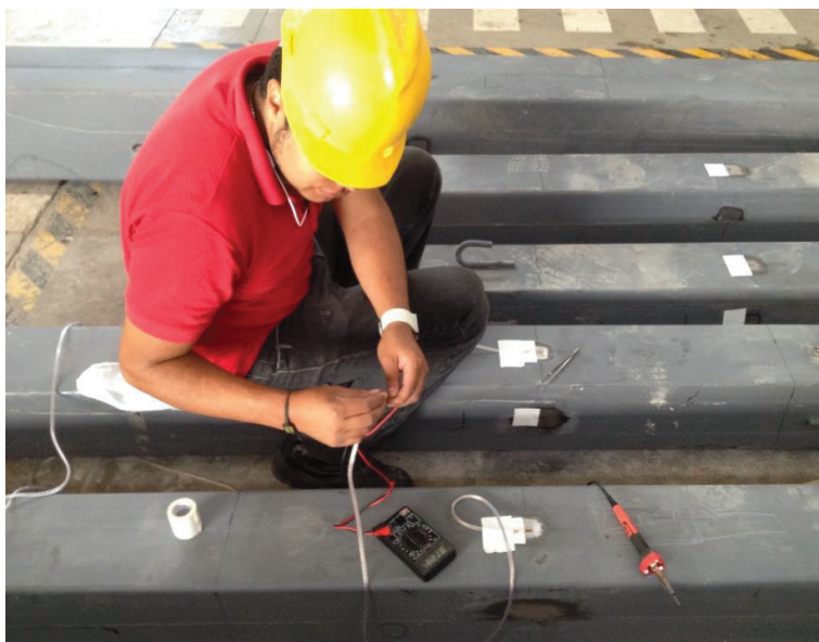
Fotografía 4.7 Instalación de strain gages
