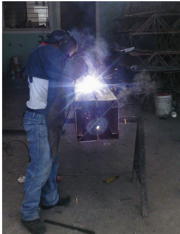
Fotografía 4.1 Soldado de perfiles
