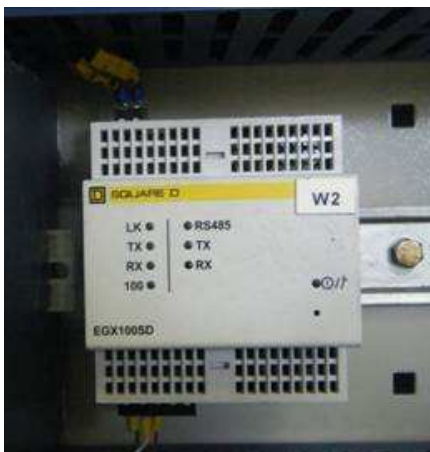
Figura 6.7. Instalación del Equipo de Comunicación EGX100
