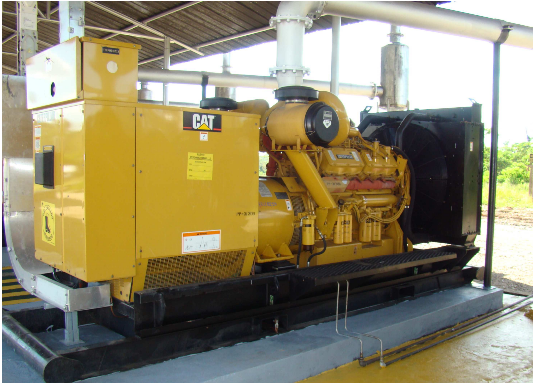
Figura 3.3. Grupo Electrónico Caterpillar
