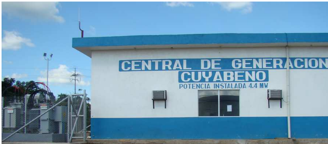
Figura 3.4. Vista Frontal de la Sala de Control
