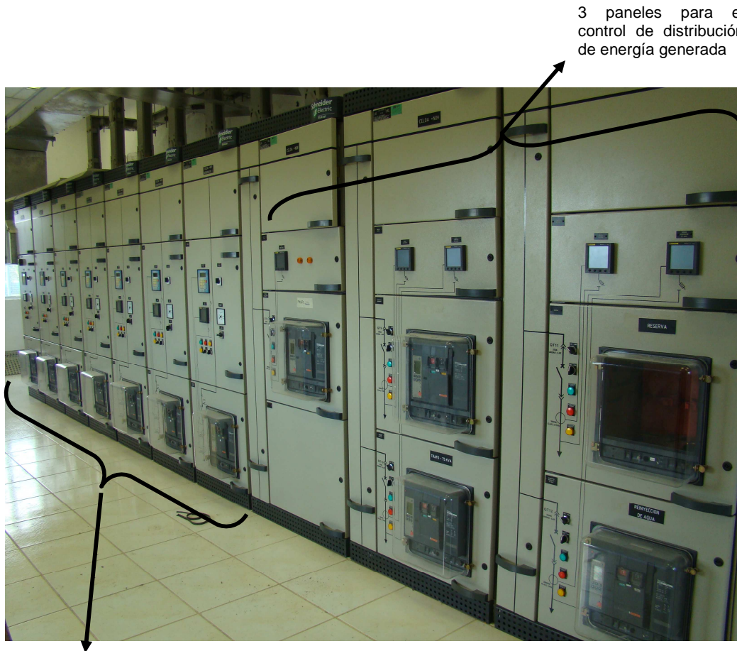
Figura 3.6. Paneles de Control
