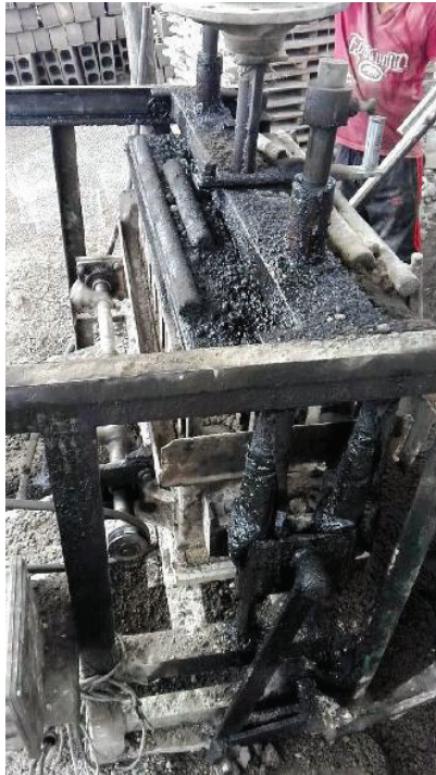
FOTO 2.11 ETAPA DE PRENSADO EN LA FABRICACIÓN DE BLOQUES DE HORMIGÓN
