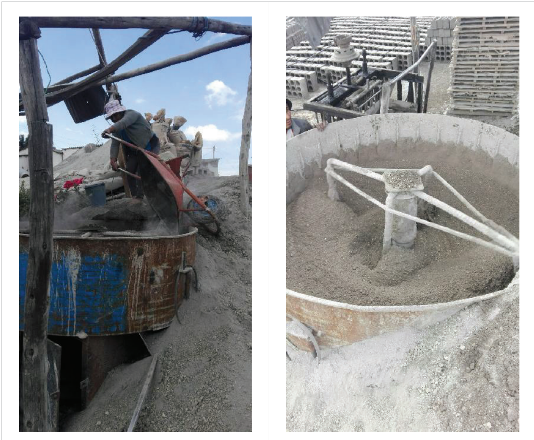
FOTO 2.10 PREPARACIÓN DE LA MEZCLA PARA LA FUNDICIÓN DE LOS BLOQUES
