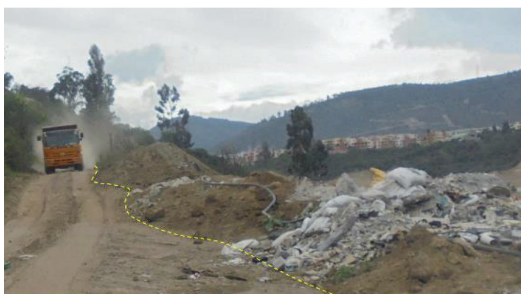
Fotografía 5.1 Sobrecarga en la ladera
