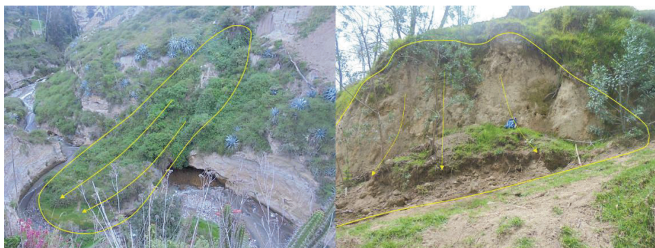
Fotografía 4.1 FRM tipo Deslizamiento Rotacional
