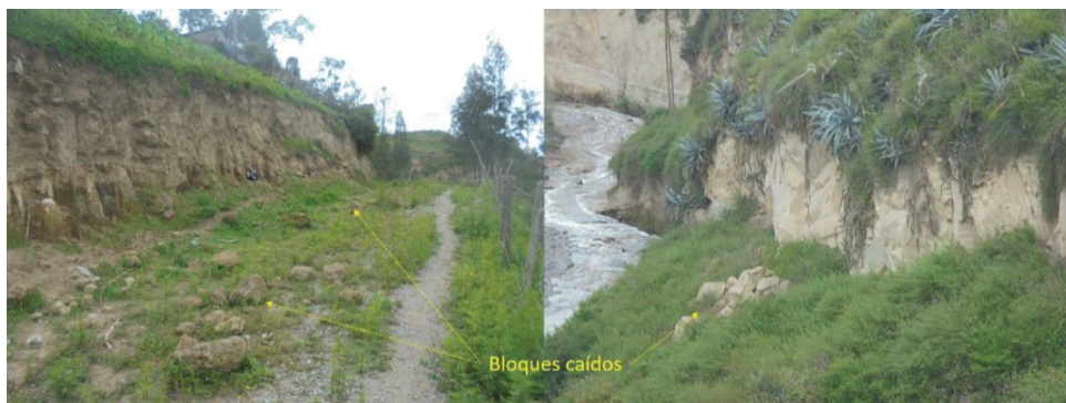
Fotografía 4.2 FRM tipo Caída de Bloques
