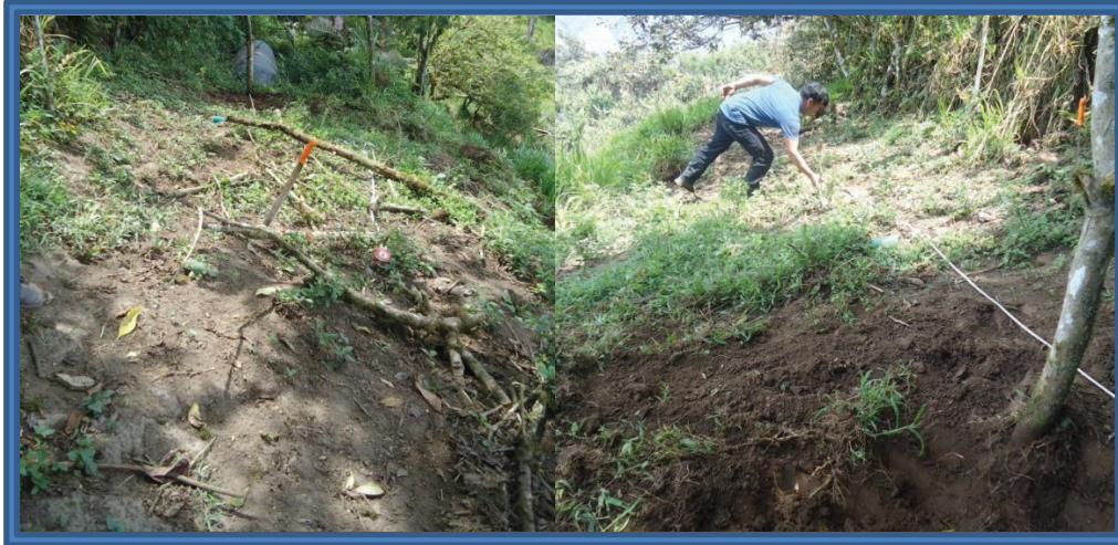
IMAGEN 3.5. Limpieza del terreno.
