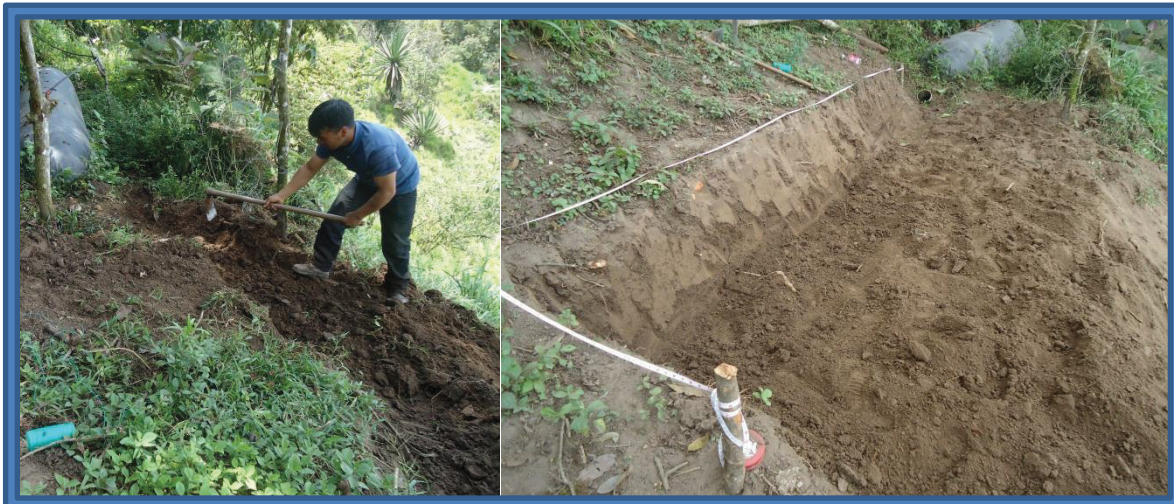
IMAGEN 3.6. Nivelación del terreno.
