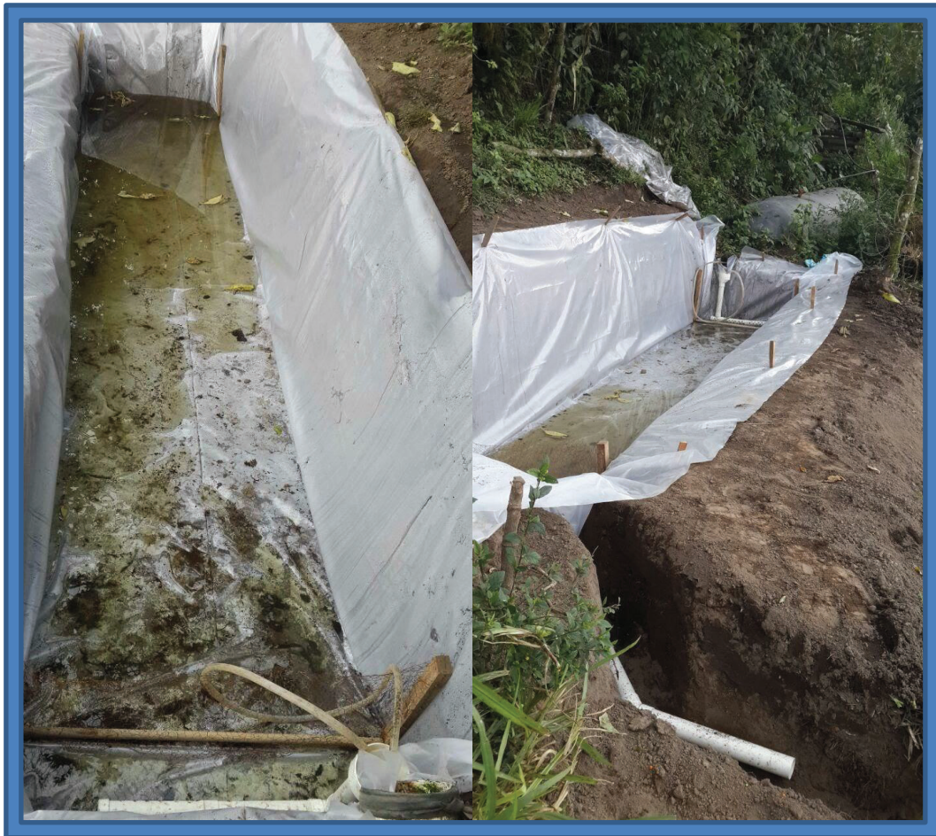
IMAGEN 3.7. Laguna instalada con geomembrana, tuberías y pantallas.
