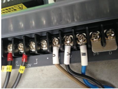
Figura 189. Verificación de la conexión del circuito de potencia. (Fuente: Autores).
