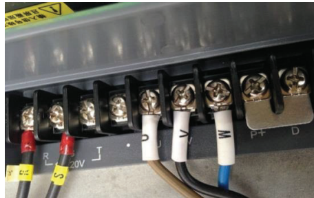
Figura 190. Verificación de la conexión del circuito de control. (Fuente: Autores).
