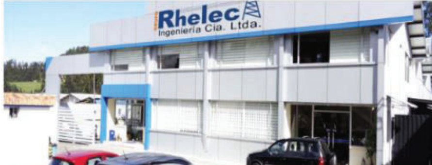
Figura 2. Fachada Frontal Fuente: Rhelec
