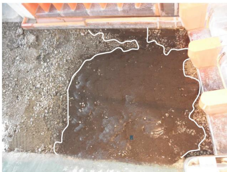
FIGURA 7.1 DISPOSICIÓN FINAL DEL MATERIAL SÓLIDO COLOCADO SOBRE EL CANAL DE APROXIMACIÓN
