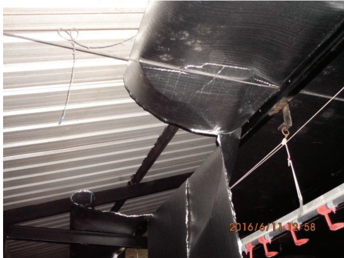
Figura 2.10. Instalación del aislante del techo, (Fuente: Autor)
