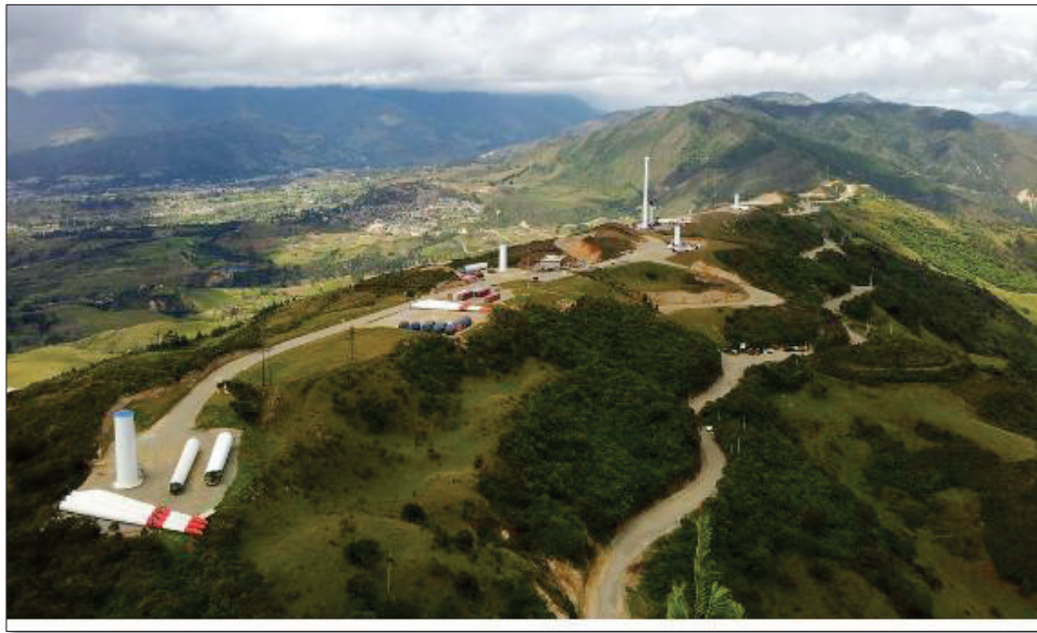
Figura 1.30. Proyecto eólico en Ecuador.
