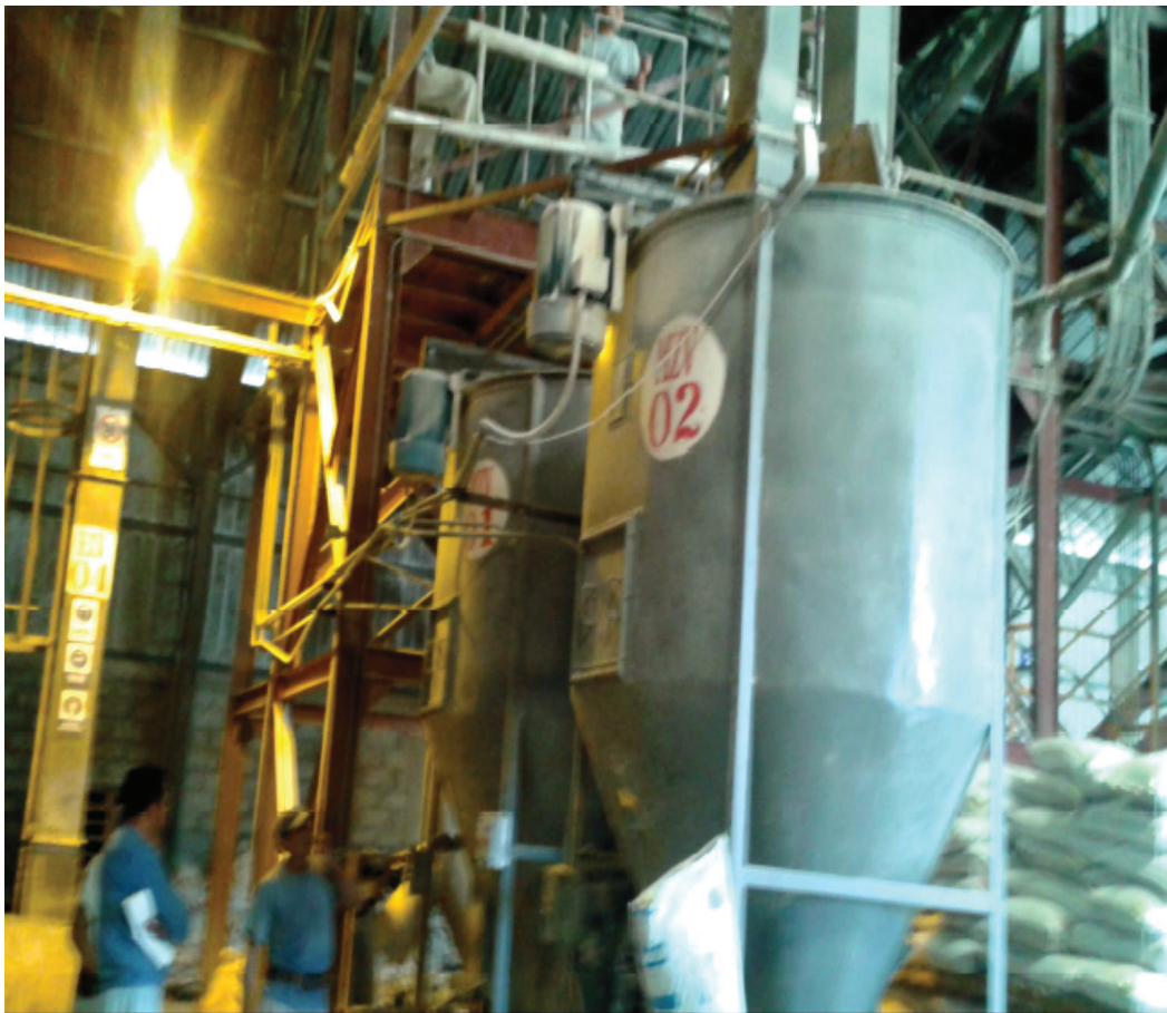
Figura 2.2 Mezcladoras de la planta de balanceado
