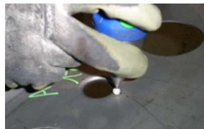
PERFORACION PUENTE ARANA P6
