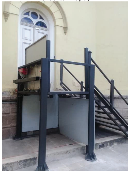
Figura 60. Vista Isométrica salvaescaleras vertical instalado. (Fuente: Propia)
