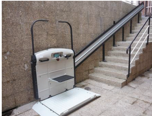
Figura 22. Bastidor de soporte lateral. (Fuente: http://www.imcaelevacion.es/salvaescaleras.html )
