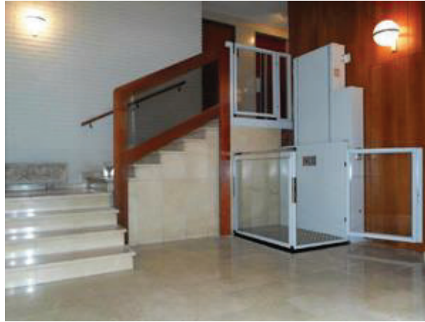
Figura 18. Apertura de puerta, sistema eléctrico. (Fuente: https://marcas.habitissimo.es/marca/mitsubishi-electric/distribuidores/alicante )
