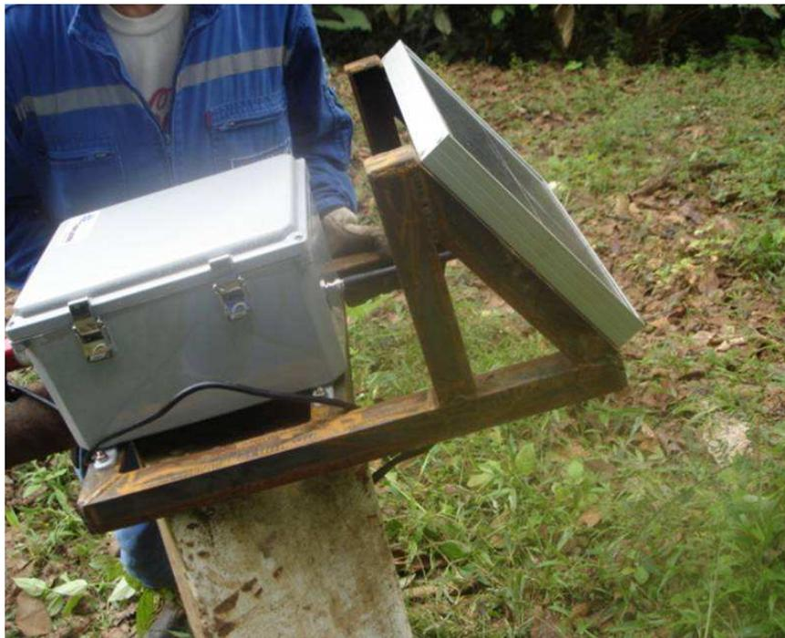
**Figura 2.25.** Instalación de la RTU en la estructura mecánica.
