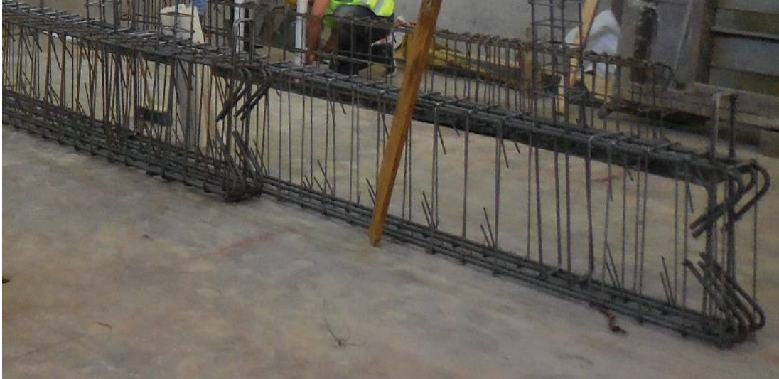
FOTOGRAFÍA 4. 1 ARMADO DE LAS VIGA DE CIMENTACIÓN DE 30x60
