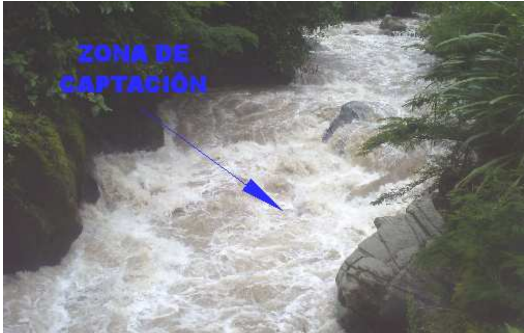
Foto 5.1: Zona de la captación en el río Alambi.
