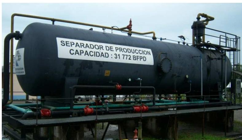
El líquido separado se envía a la bota de gas (BO-005) en donde se separa el remanente de gas de la corriente líquida y posteriormente el gas de la bota se quema en el mechero (M-010) o se envía a Petroindustrial para su respectivo proceso.
