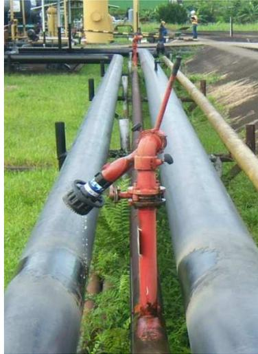
Cabe recalcar que además que existe un monitor de espuma que funcionan de manera análoga a los monitores de agua.
