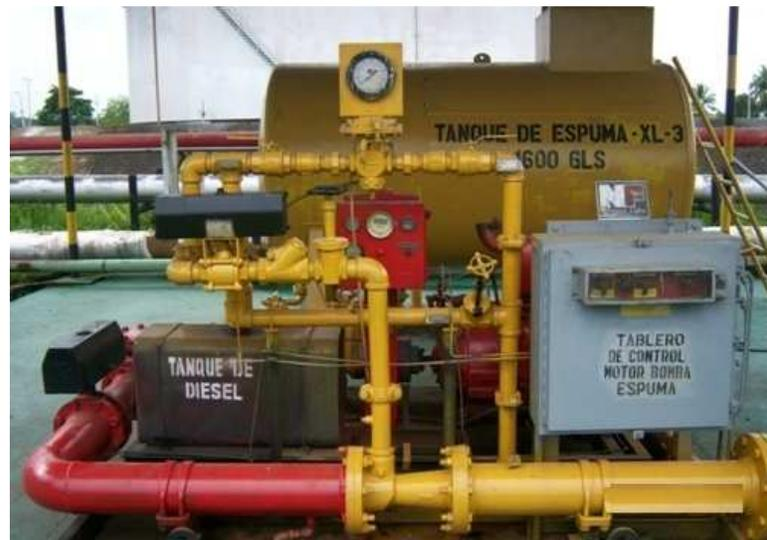
El sistema de espuma-agua alimenta a los monitores de espuma y a los Tanques de Almacenamiento de la estación pasando previamente por el foam-maker, la espuma ingresa a los Tanques de Lavado y de Reposo para formar un colchón de espuma que permitirá sofocar el incendio desde su interior, y los monitores enfriarán las paredes de los Tanques desde el exterior mediante chorros de agua a presión.
