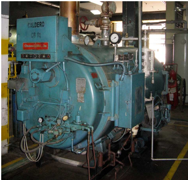
Figura A.3. 3 Caldero Power Master 3L
