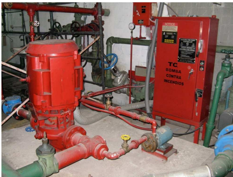
Figura A.3. 2 Sistema Contra Incendios
