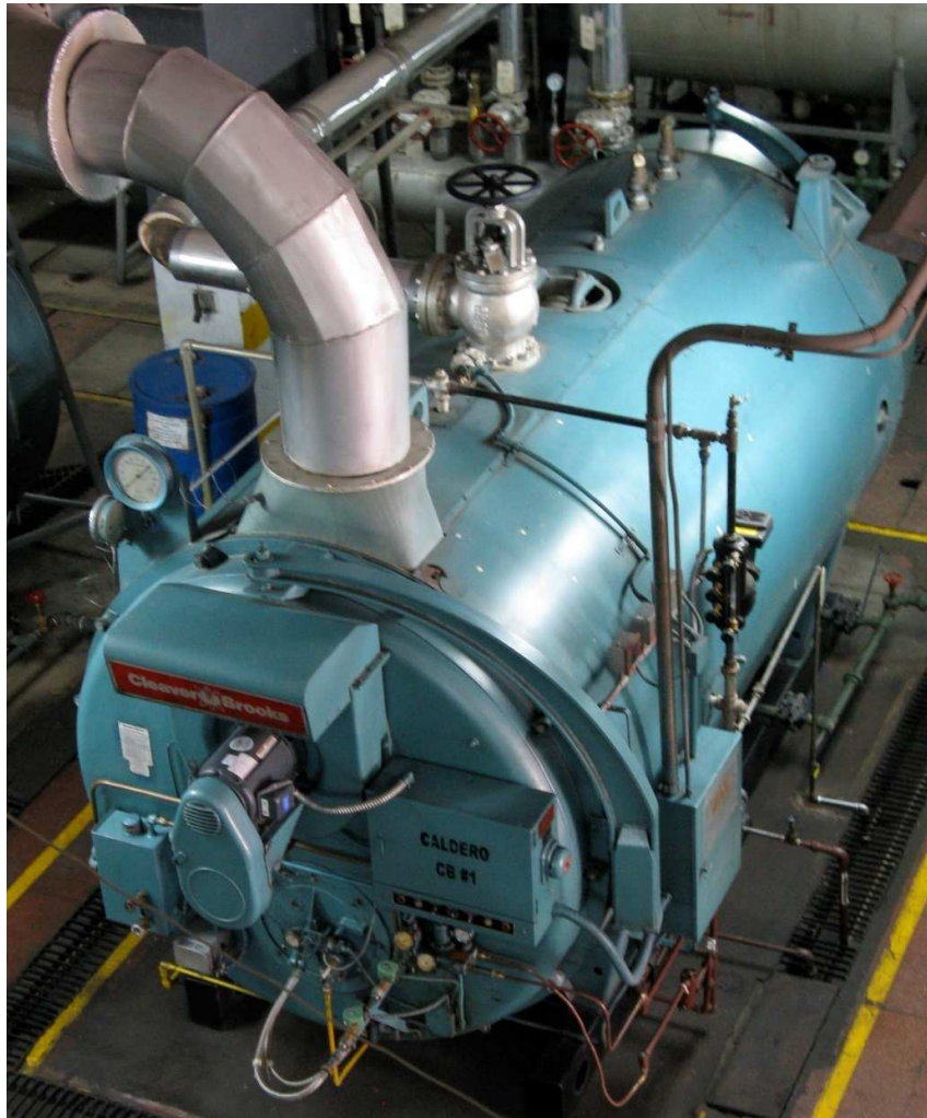
Figura A.3. 5 Caldero Cleaver Brooks CB 101-250
