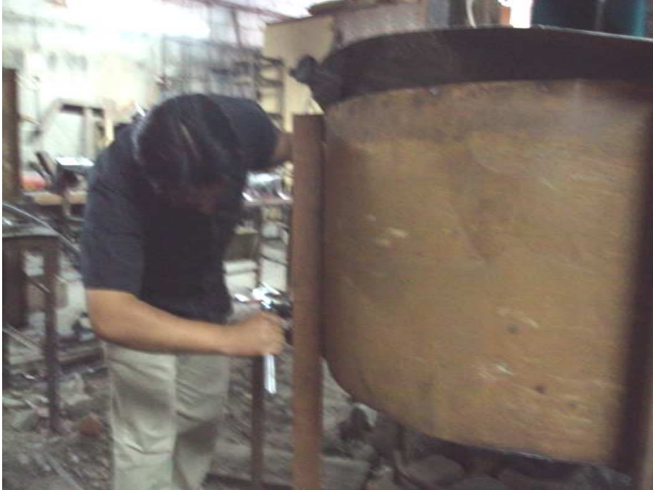
Figura 3.32 Montaje del perfil soporte
