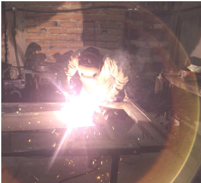
Figura 3.30 Soldadura de la tolva.
