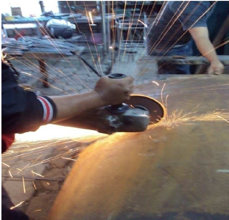
Figura 3.26 Corte de las placas metálicas
