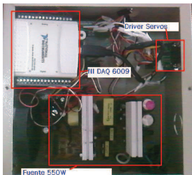
Figura 2.53 Montaje de hardware de control
