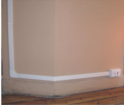
**Figura 3. 1** Sección del Cableado Estructurado montado sobre canaleta decorativa
