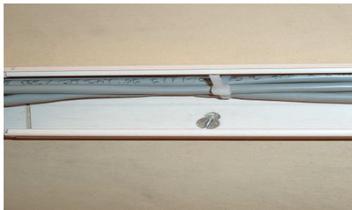
**Figura 3. 2** Sección de cable UTP montado sobre canaleta decorativa
