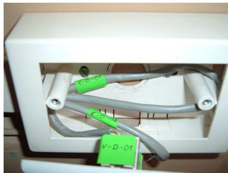
**Figura 3. 7** Salida de telecomunicaciones con sus correspondientes identificadores
