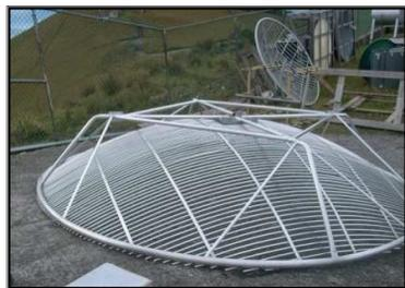
**Figura 5.73 Armado de los sectores de la antena**
