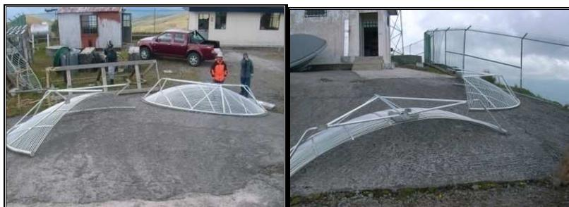
Figura 5.69 Unión de los sectores de la antena
