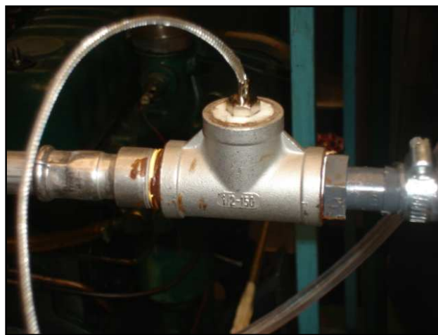
Figura 5.11. Acople y montaje de termocupla.
