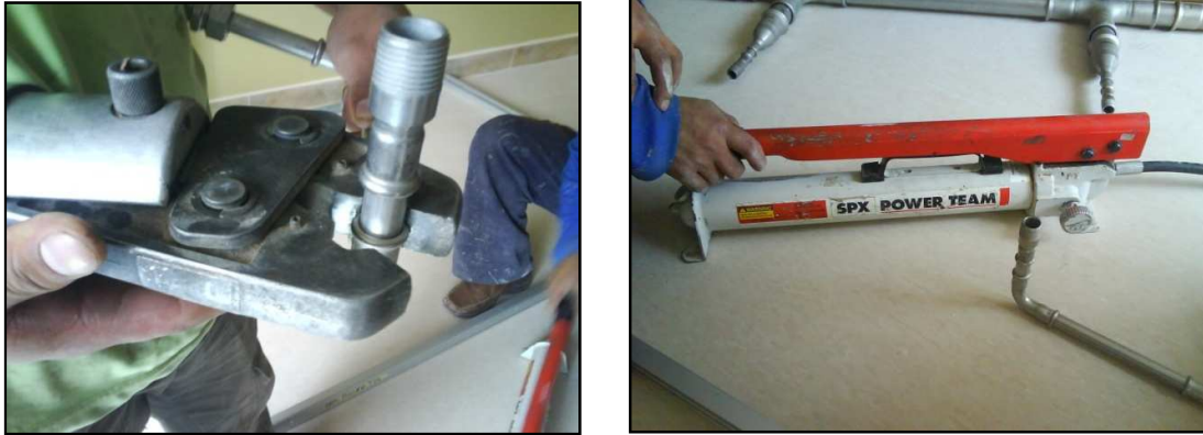
Figura 5.5. Proceso de prensado de la tubería.
