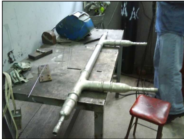
Figura 5.6. Proceso de soldadura del tapón con la tubería interior.
