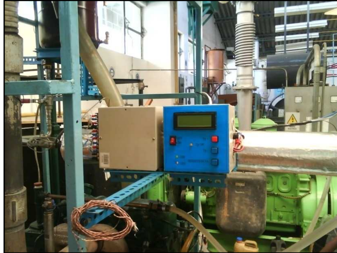
Figura 5.17. Montaje del sistema de control.
