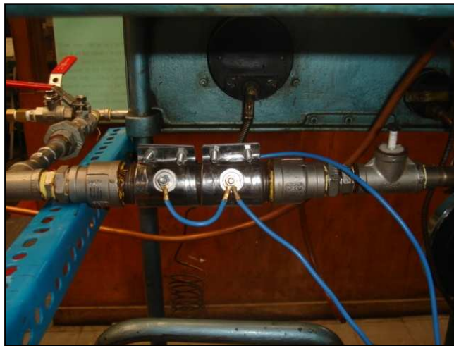
Figura 5.12. Montaje de la resistencia eléctrica de calentamiento.
