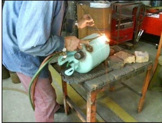
Figura 5.7. Proceso de soldadura del tanque.
