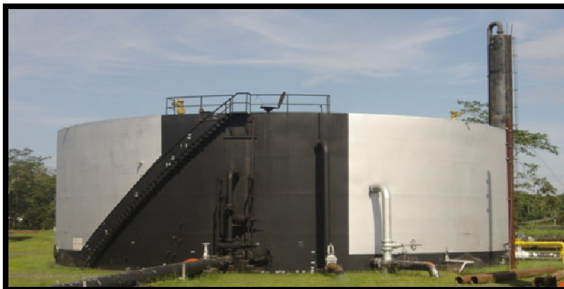
Foto 1.4: Tanque de reposo estación Sacha Central
