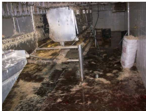
Figura 3.7. Rejas de evacuación del área de Desplumado cubierto de plumas
