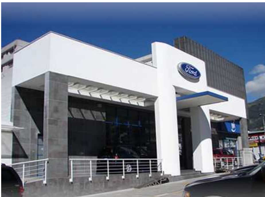
Fig.2.1: Instalaciones actuales de la empresa Quito Motors S.A.C.I.
