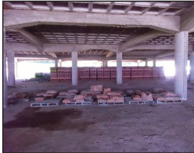
Figura 2.16: Sistema pórtico-vigas descolgadas
