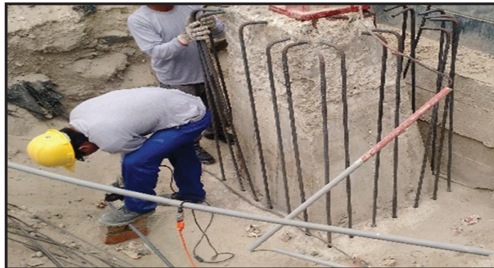
Figura 2.9: Refuerzo de zapata
