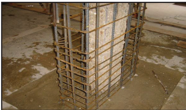
Figura 2.7: Encamisado Columnas
