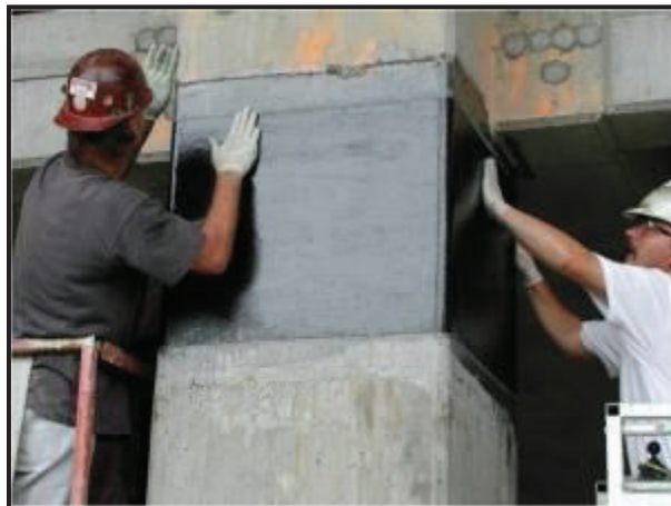
Figura 2.11: Colocación de FRP
