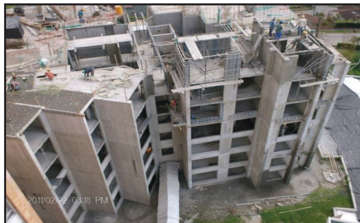
Figura 2.17: Sistema pórtico – muro estructural
