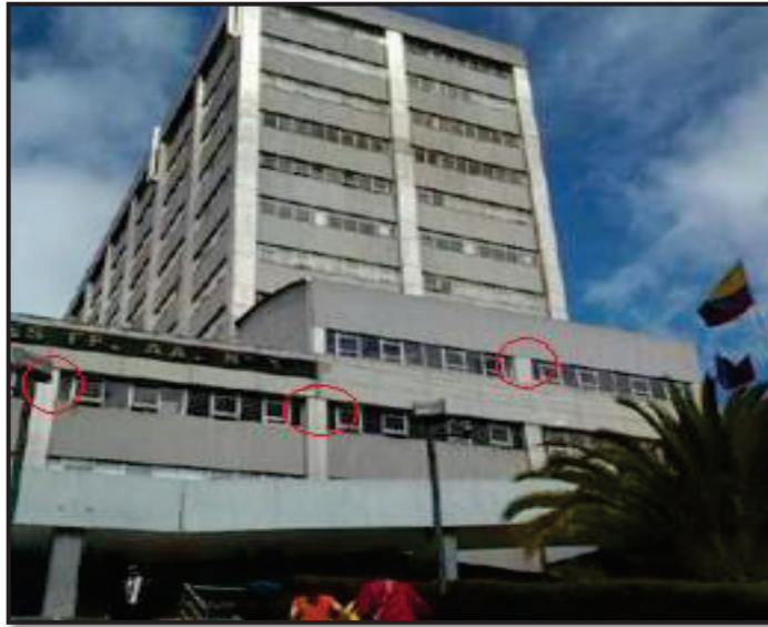
Figura 2.19: Columna corta – Hospital Militar Quito
