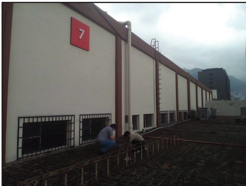
Figura 3.5: Vista lateral derecha del Galpón
