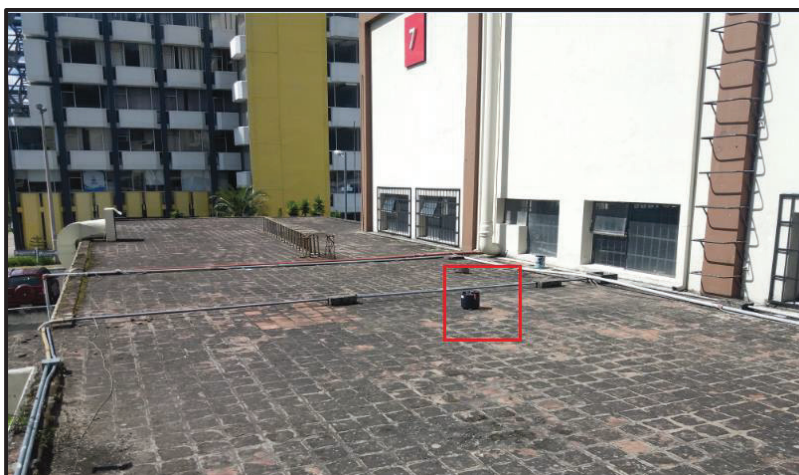
Figura 3.64: Ubicación del equipo en la parte alta de la estructura aledaña a Galpón N°7 “Casa Mata”
