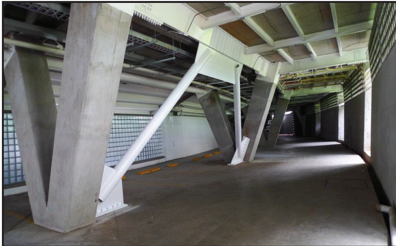
Figura 2.12: Arriostramientos
